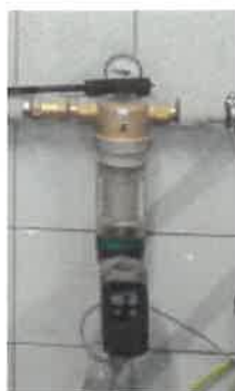
Rys. 30 Widok ogólny filtra samopłuczącego
